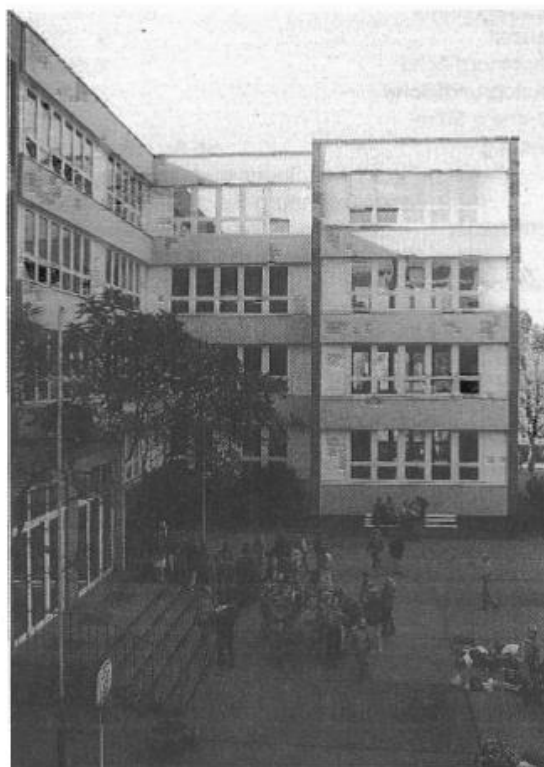
Gebäudetyp Rostock in Niepars/Mecklenburg-Vorpommern nach Sanierung der Außenhaut
